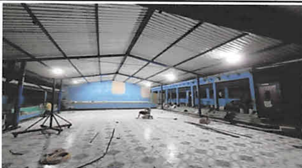
Foto 2: MANTENIMIENTO A ENERGIA ELECTRICA EN GALERA
