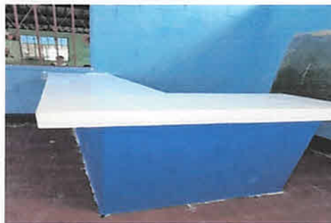
Foto 6: ELABORACIÓN DE PASAMANO DE CONCRETO
